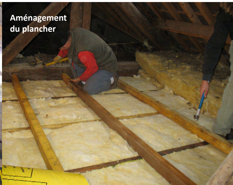
Pose du nouvel isolant avec lambourdes pour support du nouveau plancher
