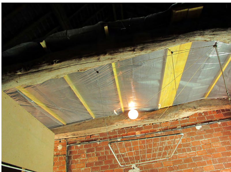
Pose de l'ossature
