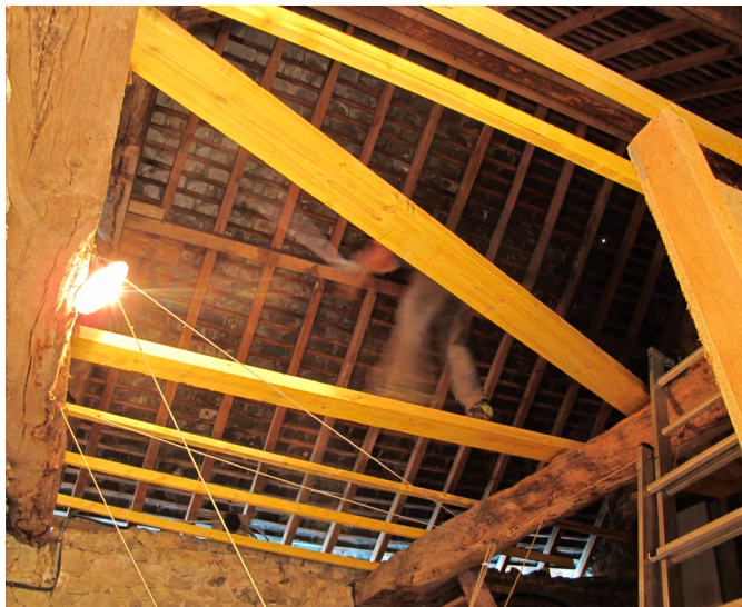
Pose de l'ossature
