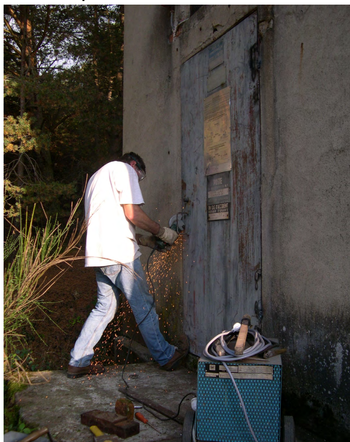
Pose d'une porte sur le transformateur
